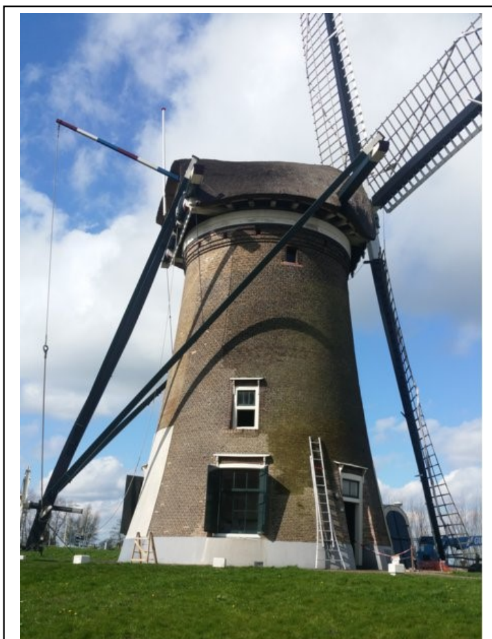
FOTO VAN SCHILDERWERKZAAMHEDEN AAN MALLEMOLEN DOOR SCHILDERWERKEN VAN DE VELDE B.V. TE BERGAMBACHT; VOORJAAR 2016.
