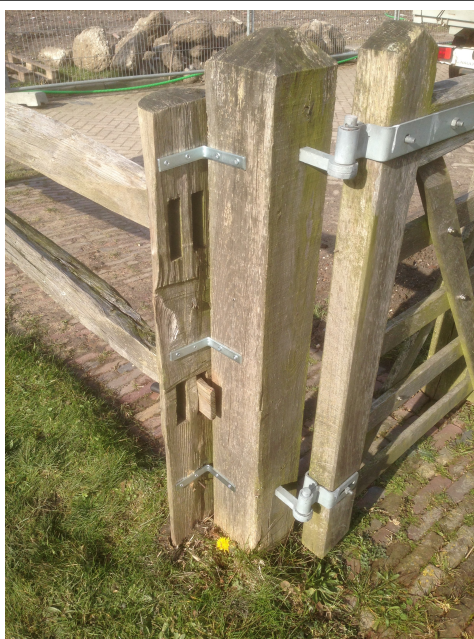
FOTO VAN DOOR DE VERENIGING IN EIGEN BEHEER UITGEVOERDE REPARATIEWERKZAAMHEDEN AAN HET HEKWERK RONDOM DE MALLEMOLEN; FOTOGRAAF DICK VAN POPERING, 5 MAART 2016.
